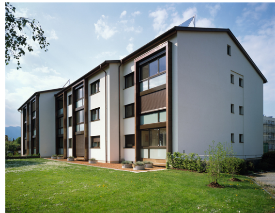
Foto: Wohnanlage Rankweil-Schleipfweg nach Sanierung
