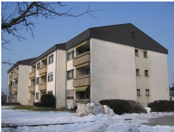
Foto: Wohnanlage Rankweil-Schleipfweg vor Sanierung
