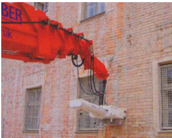
Foto: Fassadenfräse im Einsatz
