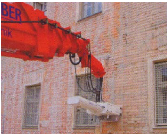
Foto: Fassadenfräse im Einsatz
