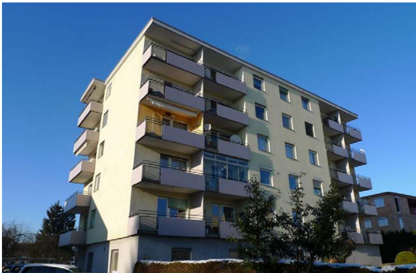
Foto: Mehrfamilienwohnhaus Bahnhofstr. 43, 6890 Lustenau mit WDVS aus Styropor (Baujahr 1966)
