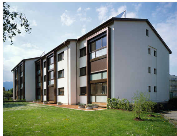
Foto: Wohnanlage Rankweil-Schleipweg nach Sanierung
