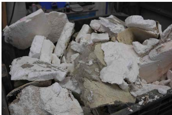
EPSolutely_Probenmaterial_maschinellem_Rückbau_WDVS.jpg © Fraunhofer Austria
