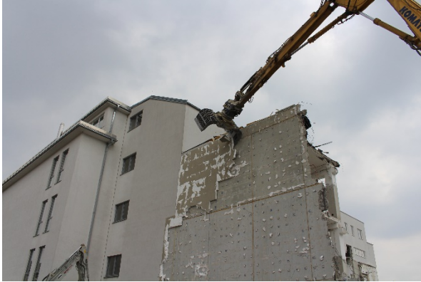
Maschineller Rückbau EPS-Fassade 2 © Fraunhofer Austria
