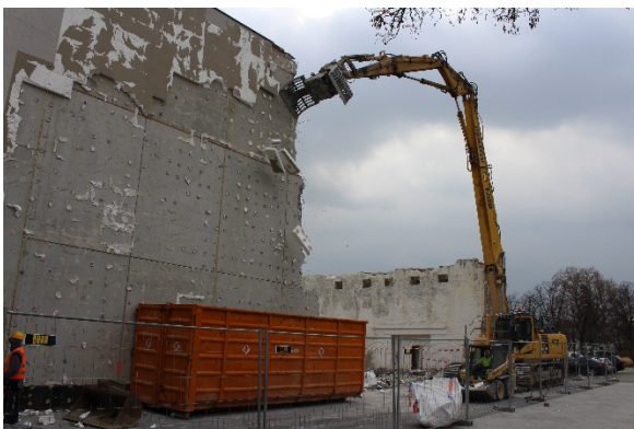
Maschineller Rückbau EPS-Fassade 1 © Fraunhofer Austria
